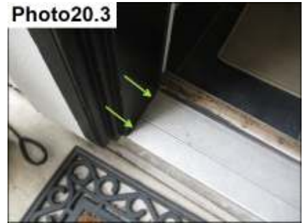
Door Miter Sealants/ Seal
