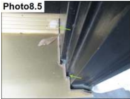
Door Miter Sealants/ Seal
