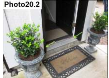
Door Miter Sealants/ Seal
