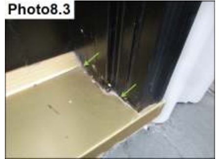
Door Miter Sealants/ Seal
