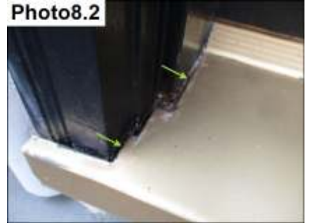
Door Miter Sealants/ Seal
